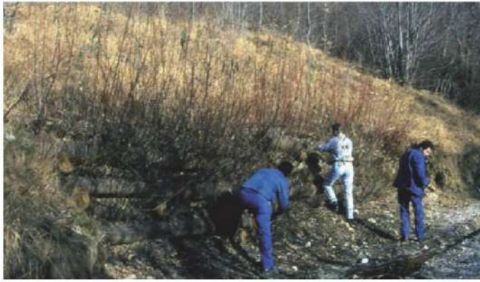
Palificata viva doppia (di versante). Intervento manutentorio di potatura
