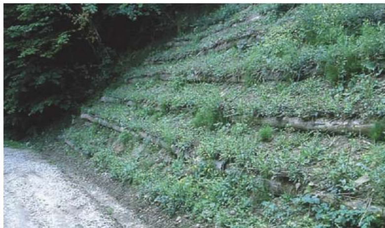
Grata viva semplice (di versante). Sistemazione finale dell'area di cantiere (in opera)
