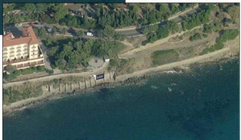
fotomontaggio intervento su ex depuratore
