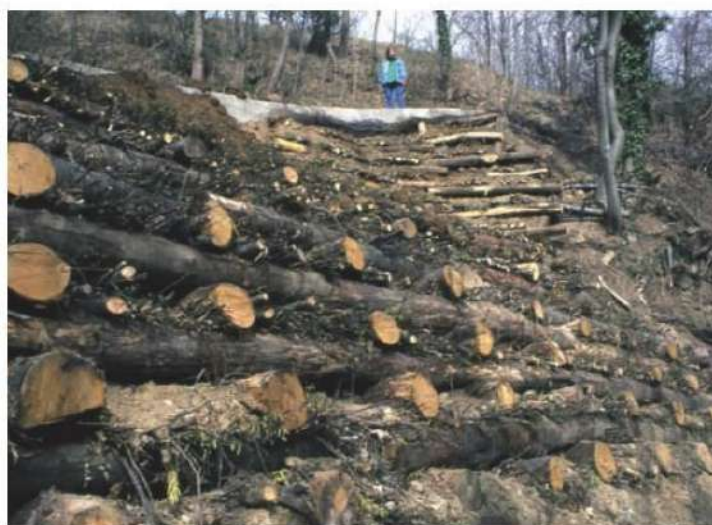
Palificata viva doppia (di versante). Come si presenta appena terminata la fase realizzativa di cantiere
