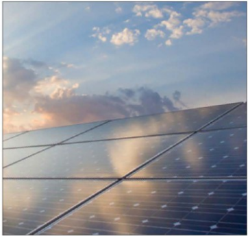
13 installazione impianto fotovoltaico
