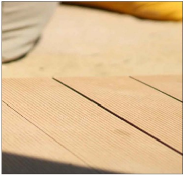
6 realizzazione deck su pennello esistente
