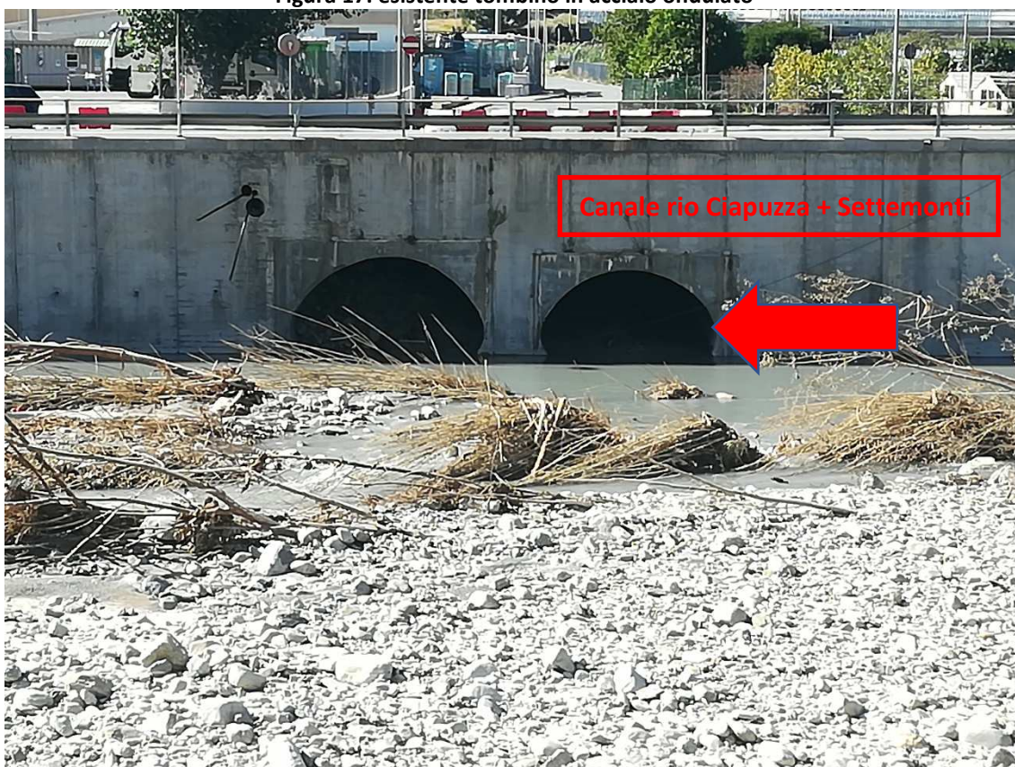
Figura 18: sbocco canalizzazione nel torrente Argentina
