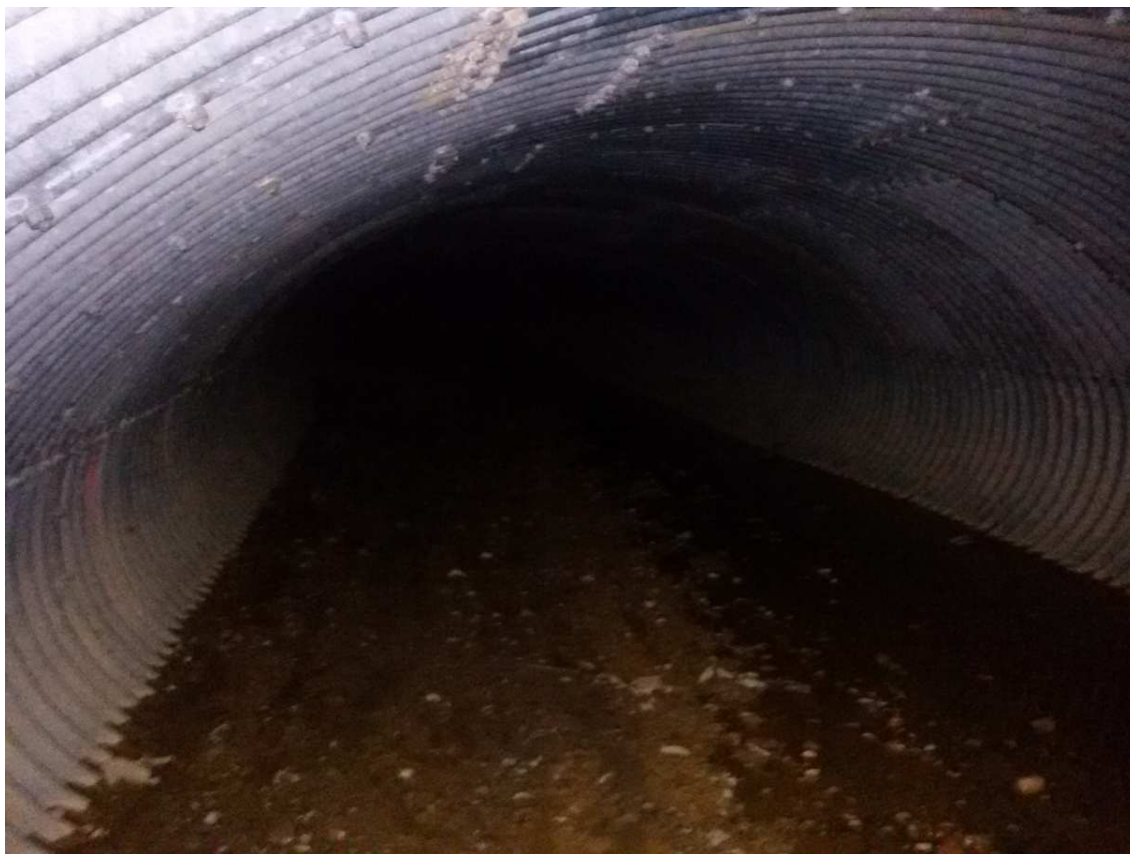
Figura 17: esistente tombino in acciaio ondulato
