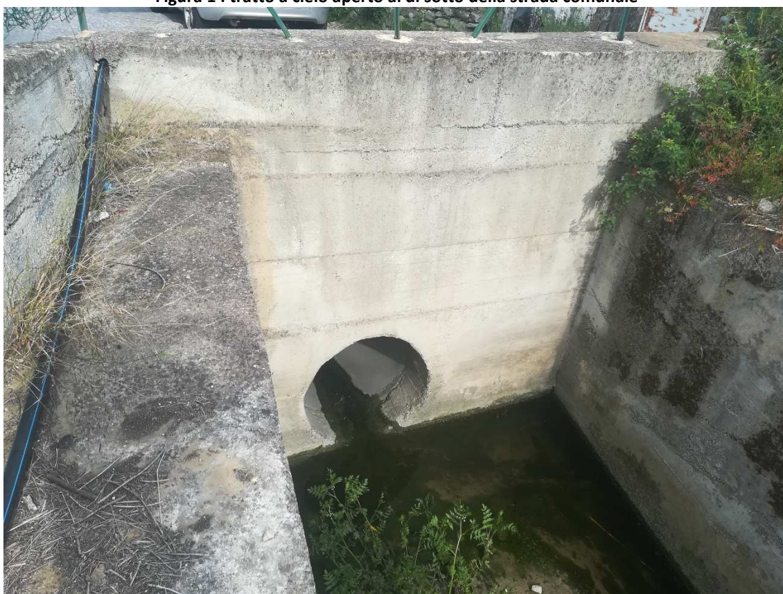
Figura 2: imbocco tombinatura DN1000
