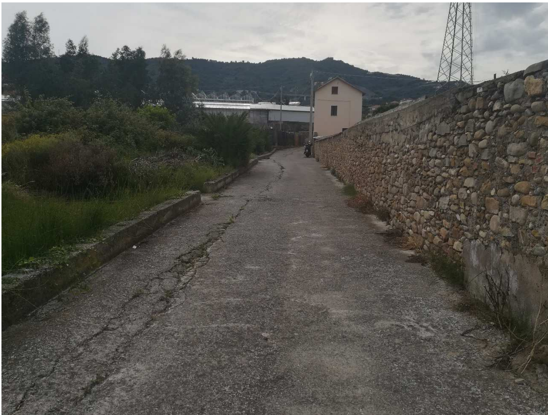
Figura 13: tratto tombinato del rio al di sotto del sedime stradale
