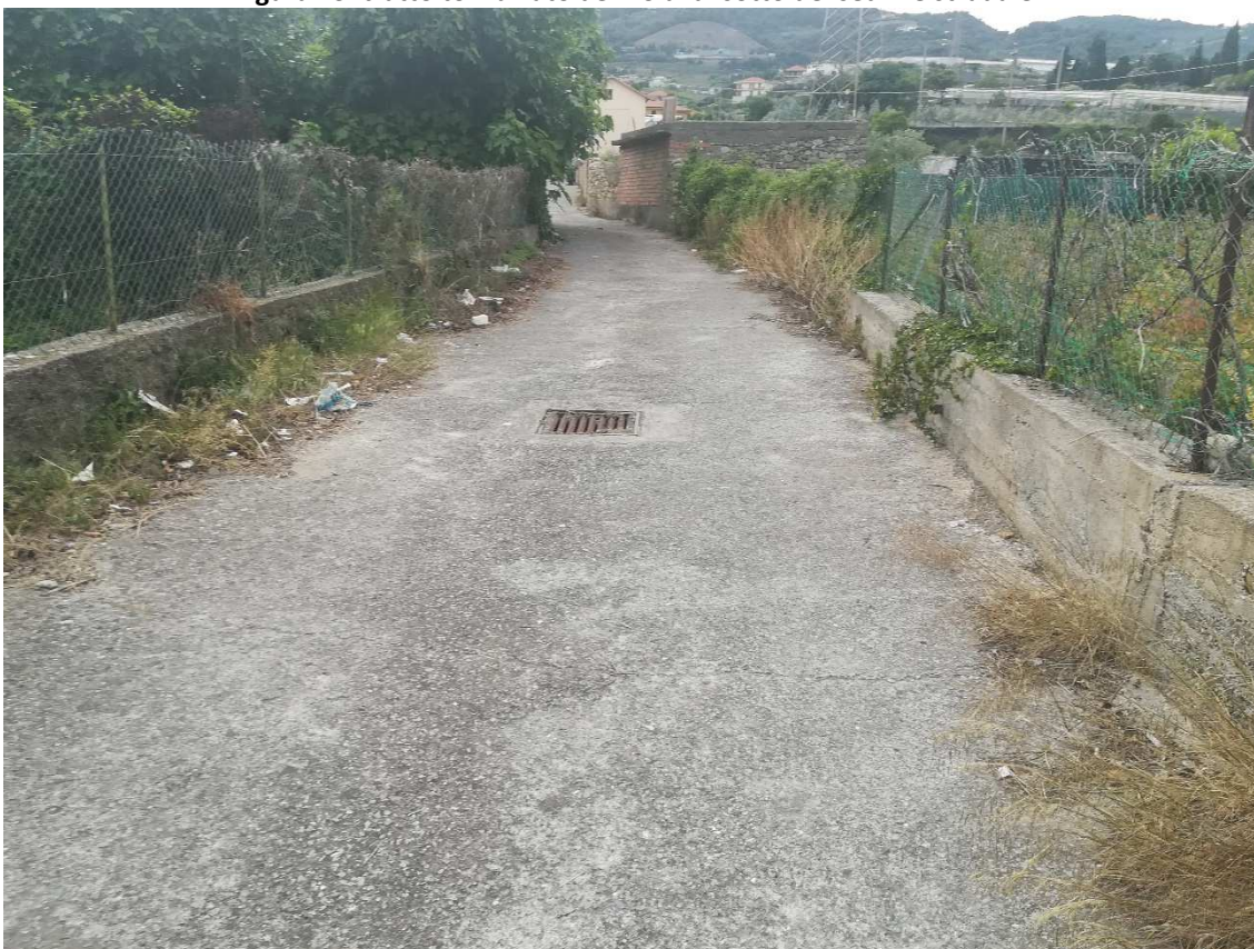
Figura 14: tratto tombinato del rio al di sotto del sedime stradale
