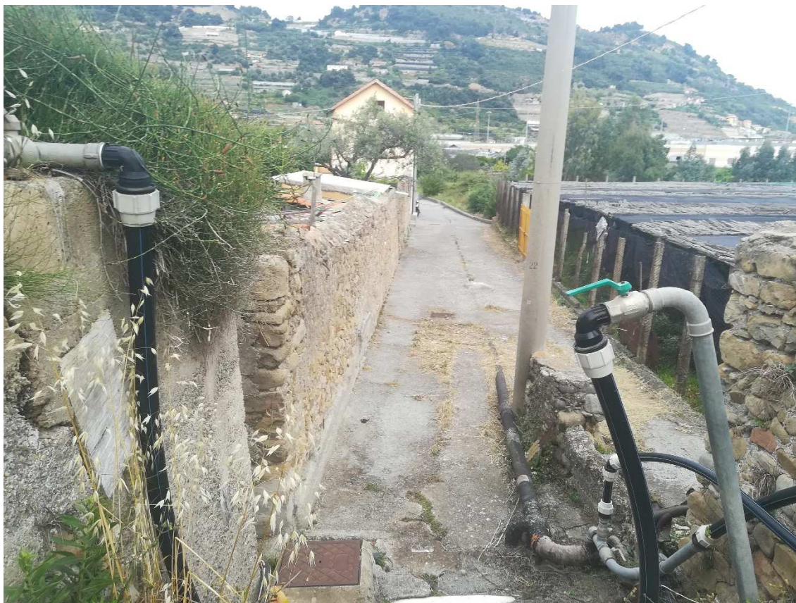
Figura 11: tratto tombinato del rio al di sotto del sedime stradale
