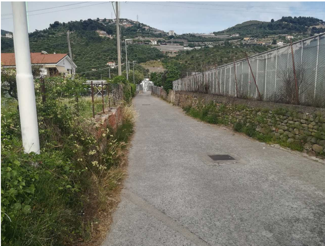
Figura 3: tratto tombinato sotto il piano stradale (DN1000)
