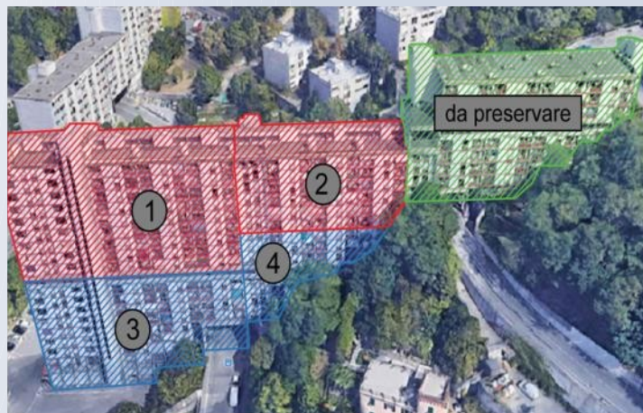
Sequenza demolizione Diga Bianca
