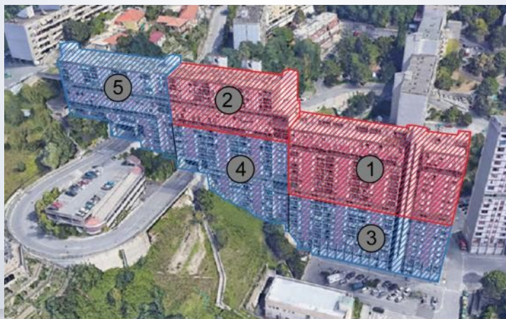
Sequenza demolizione Diga Rossa
